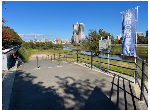
広瀬橋上流右岸（10/30）
