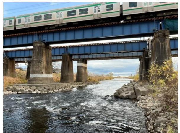
JR鉄橋(上流より撮影) 12/4
