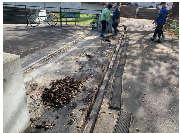
(同左) 堤防の側溝清掃
