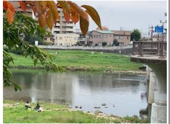
広瀬橋(長町側から対岸河原町)10/3 広瀬川
