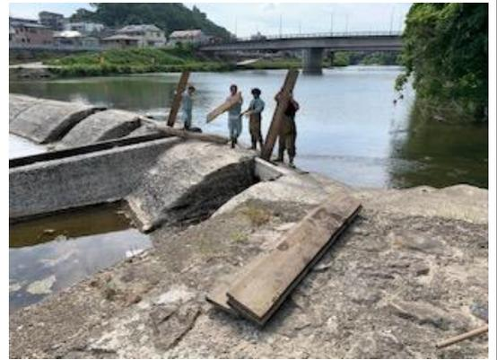
老朽化の愛宕堰（取水の角落しは危険な作業業）
