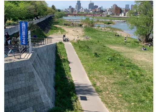
広瀬橋上流右岸(5/6)
