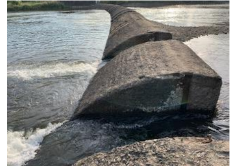
愛宕堰左岸（左下流）10/1 撮影
