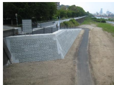
（スロープ工事中完成7/1）
