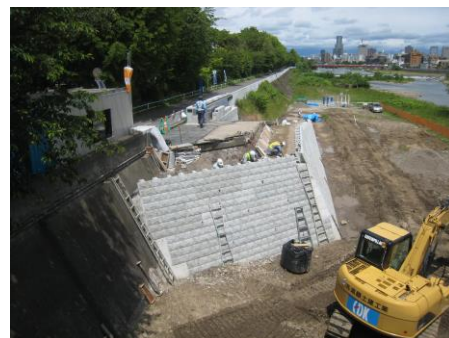
（広瀬橋上流スロープ工事中6/9）
