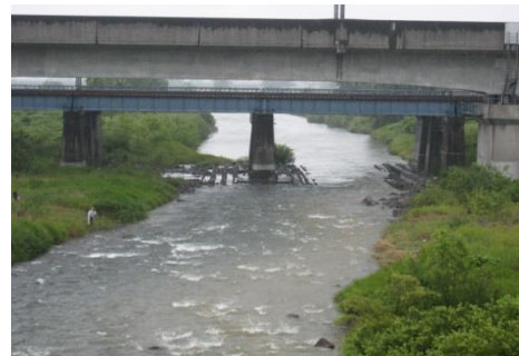
(7/01 広瀬橋下流・新幹線橋脚)
