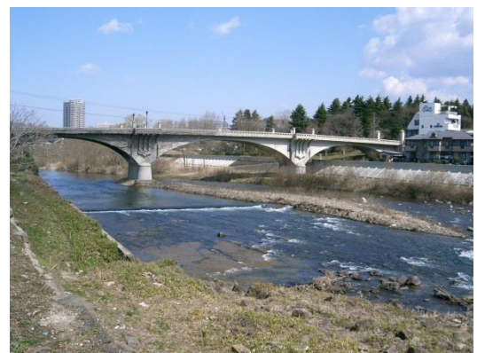
(青葉区大手町の大橋下流右岸追廻から)
