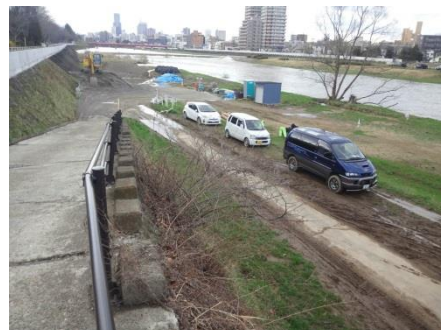
(広瀬橋上流 右岸 4/4)
