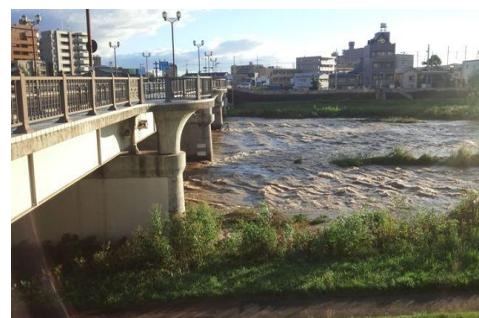
(10/03 台風明けの広瀬橋下流)
