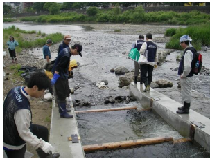
6月 郡山堰新魚道
